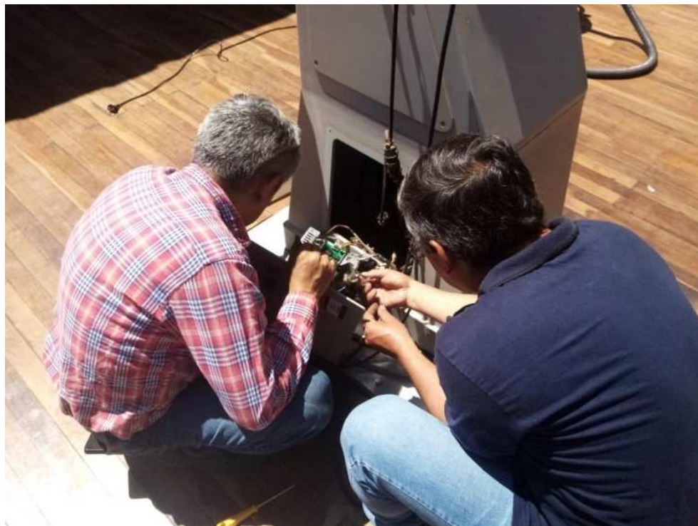
Revisión de placas electrónicas y fusibles.
