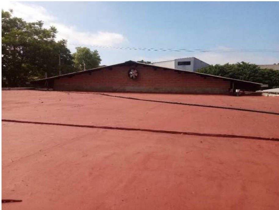
Impermeabilización del techo de hormigón del edificio.
