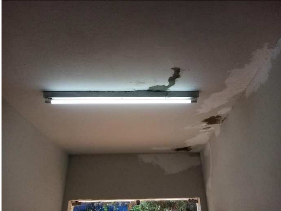
Proceso de reparación (pasillo de acceso).
