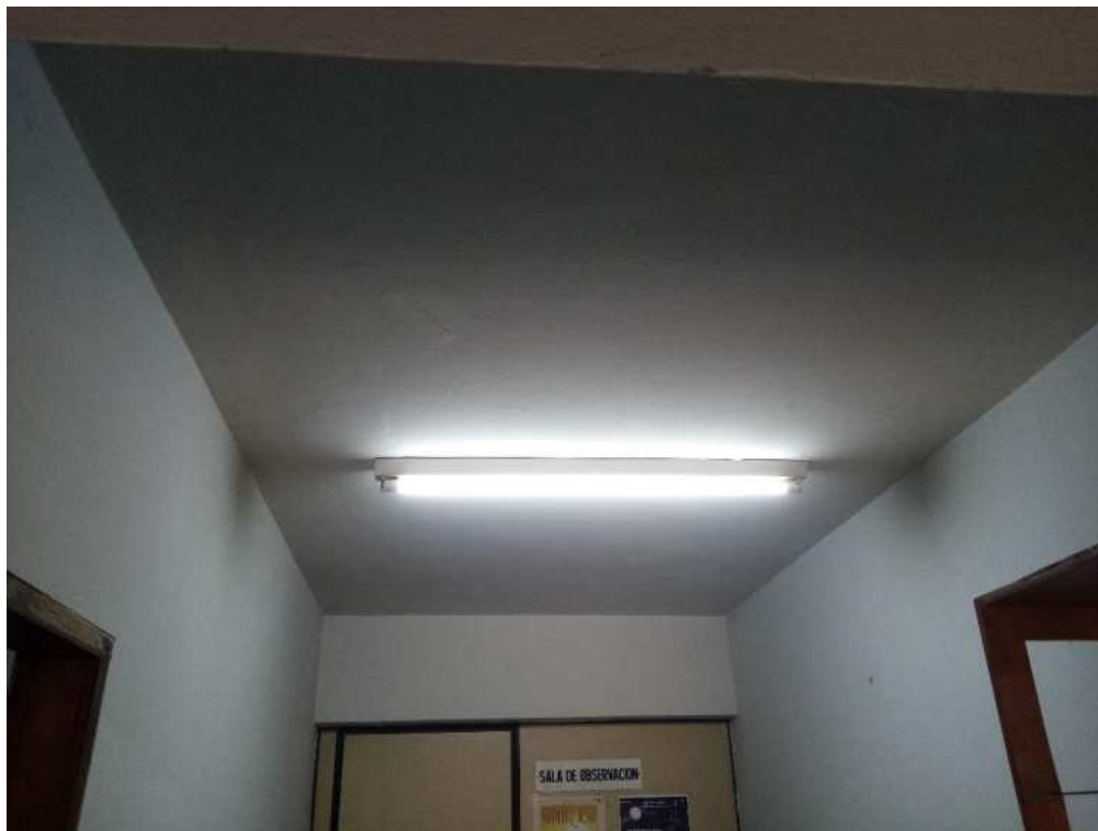
Trabajo finalizado (pasillo de acceso).
