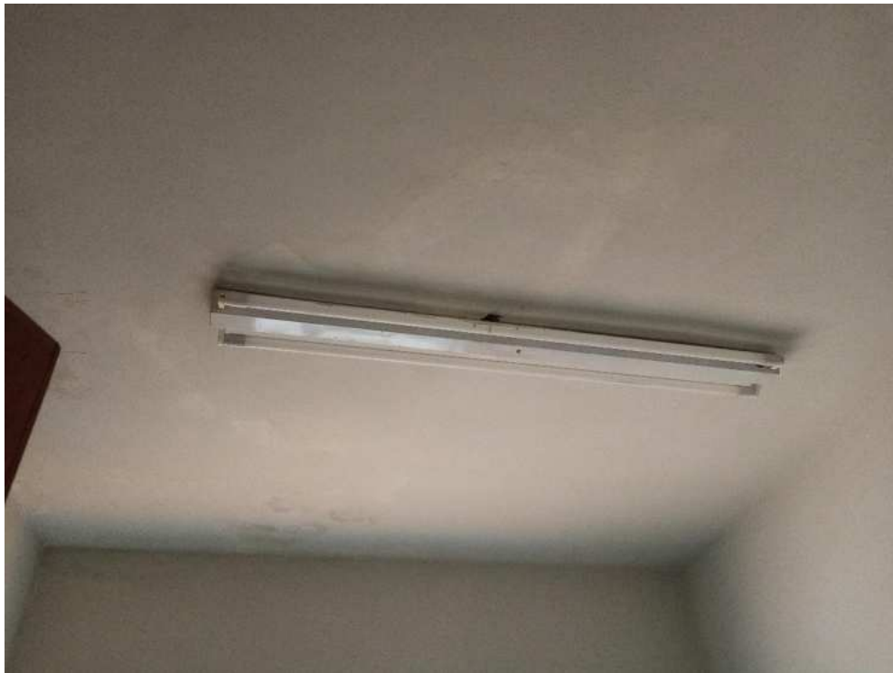
Etapa de reparación (cocina).
