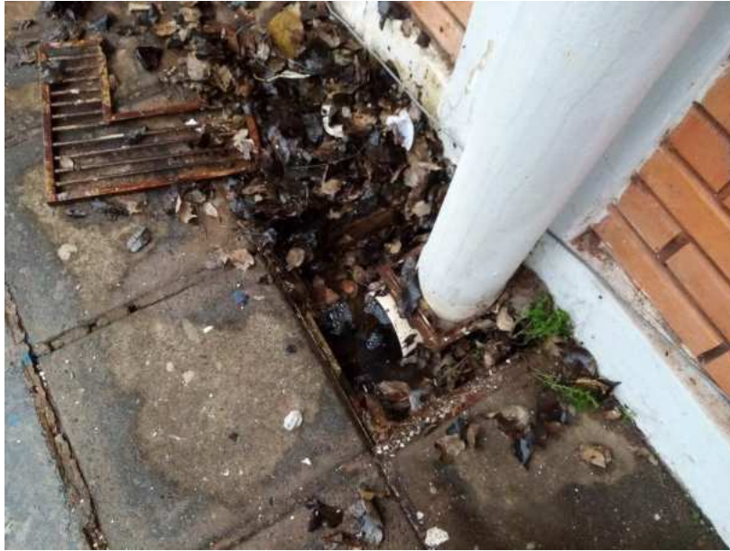
Limpieza de las rejillas de desagüe.
