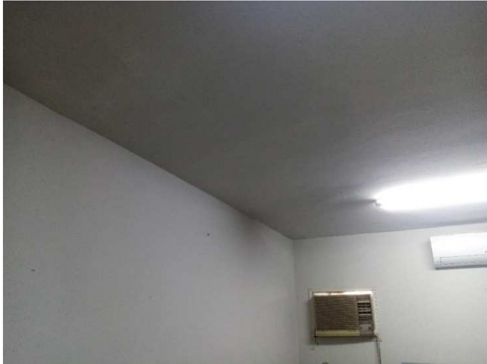
Trabajo finalizado (sala de control).
