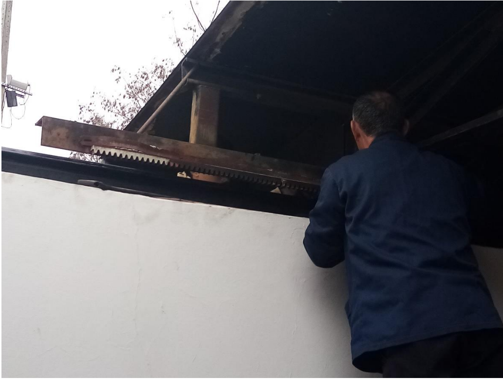
B.2 Reparación del controlador del telescopio principal.
